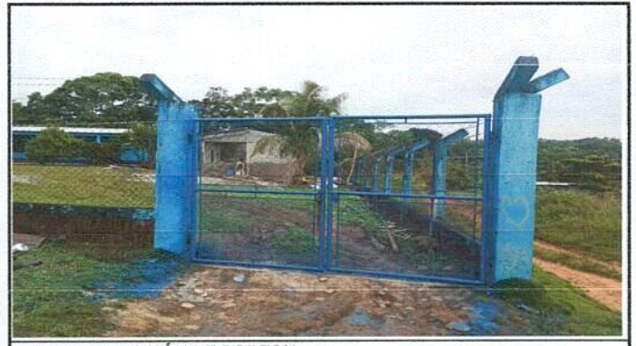
Foto 6: REPARACIÓN DE PORTON
