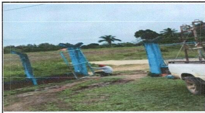
Foto 6: REPARACIÓN DE PORTON
