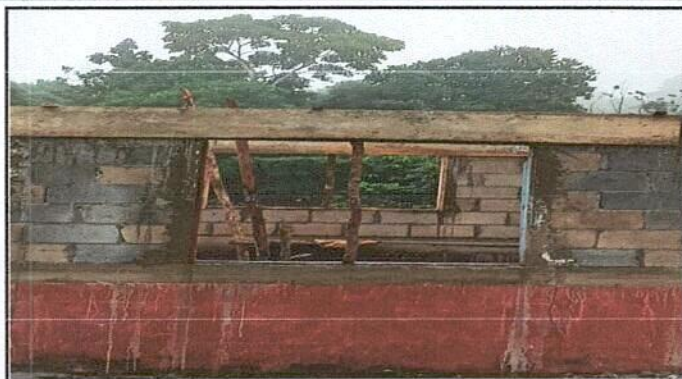
Foto 2: FABRICACIÓN E INSTALACIÓN VENTANA DE METAL
