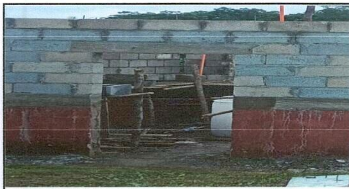
Foto 5: SUSTITUCIÓN DE PURTA DE MADERA POR METAL
