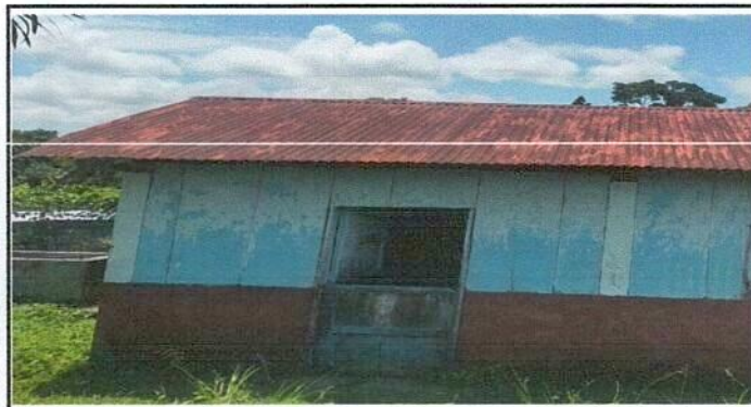
Foto 5: SUSTITUCIÓN DE PURTA DE MADERA POR METAL
