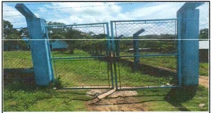
Foto 6: REPARACIÓN DE PORTON
