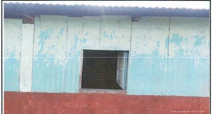
Foto 2: FABRICACIÓN E INSTALACIÓN VENTANA DE METAL
