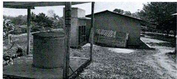
Foto 4: Vista de pozo y baños
