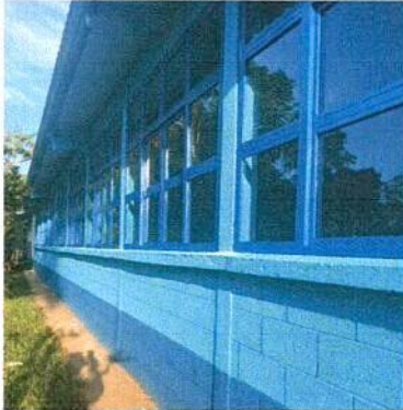
Foto1: Sustitucion de ventanas de madera por metal mas vidrio.
