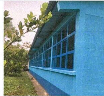
Foto 2: sustitucion de ventanas de madera por metal mas vidrio
