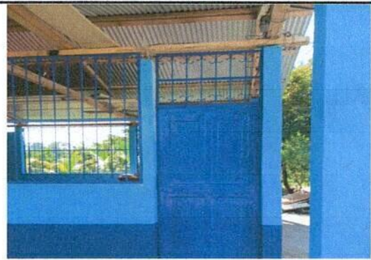
Foto 4: sustitucion de puertas de metal
