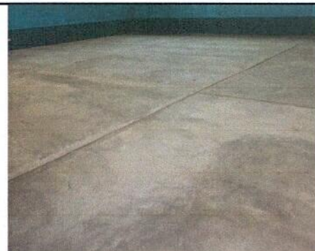
Foto 6: reparacion de piso de torta de concreto
