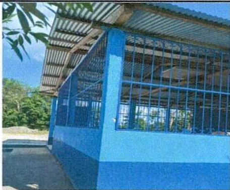
Foto 3: sustitucion de balcones de metal
