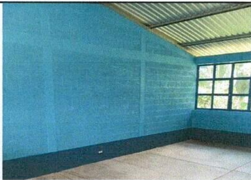
Foto 5: pintura de muros exteriores e interiores
