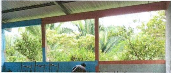
Foto 1: Sustitucion de ventanas de madera por metal mas vidrio.
