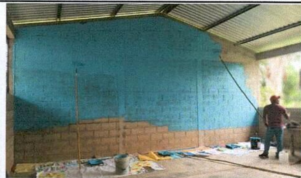
Foto 5: pintura de muros exteriores e interiores
