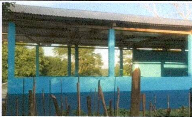
Foto 3: sustitucion de balcones de metal
