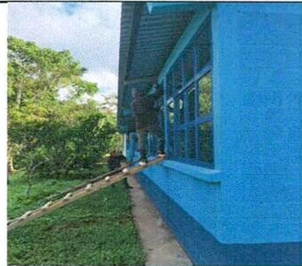
Foto 2: sustitucion de ventanas de madera por metal mas vidrio
