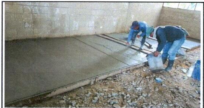
Foto 6: reparacion de piso de torta de concreto
