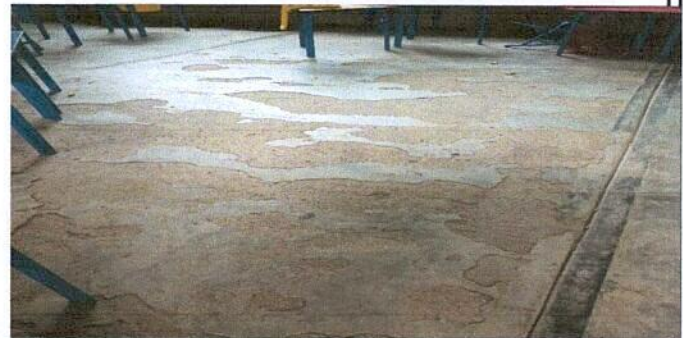
Foto 6: reparacion de piso de torta de concreto
