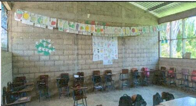
Foto 5: pintura de muros exteriores e interiores
