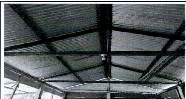
Foto 4: cambio de estructura de madera por metal
