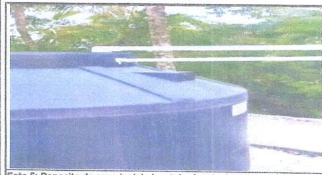
Foto 5: Deposito de agua instalado y tubería principal de pvc.
