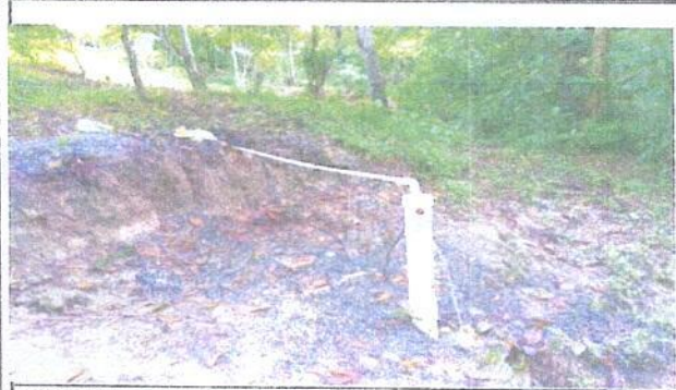
Foto 3: Pozo mecanico terminado.
