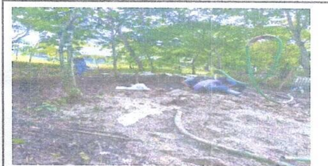
Foto 3: avances de los trabajos en pozo.
