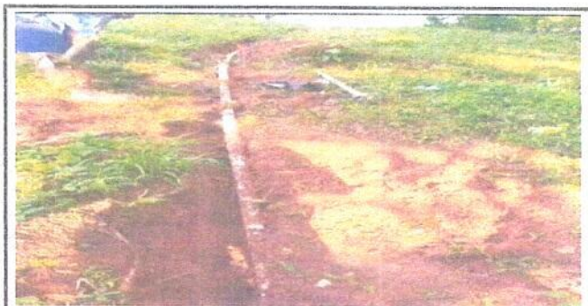
Foto 5: Zanqueo para tubería principal de servicio de agua.
