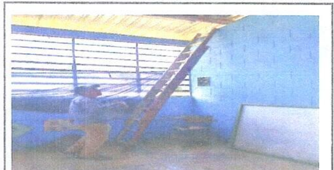
Foto 4: avance en los trabajos de remozamiento.
