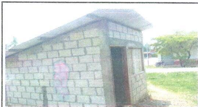
Foto 3: Vista de las instalaciones del pozo.
