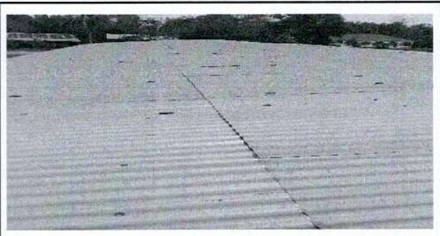
Foto 2: Cambio de techo por laminas troqueladas
