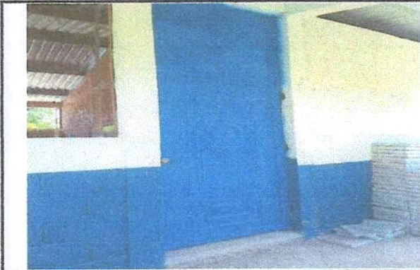
Foto 1: Sustrucción de puerta
