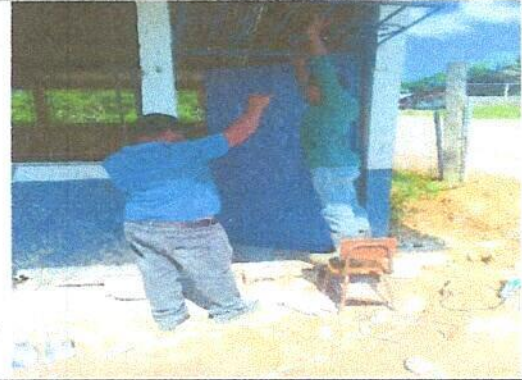
Foto 2: Sustitución de puerta
