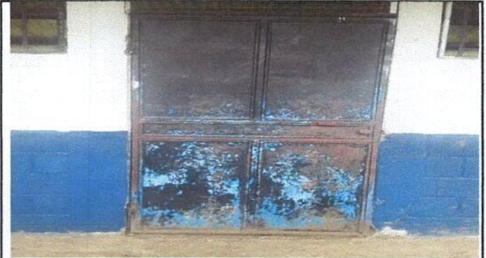
Foto 2: Sustrucción de puerta
