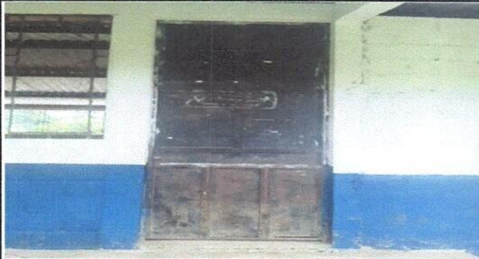
Foto 1: Sustrucción de puerta
