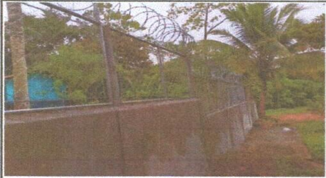
Foto 1: VISTA GENERAL DEL MURO PERIMETRAL, 2.30 MTS DE ALTURA.
