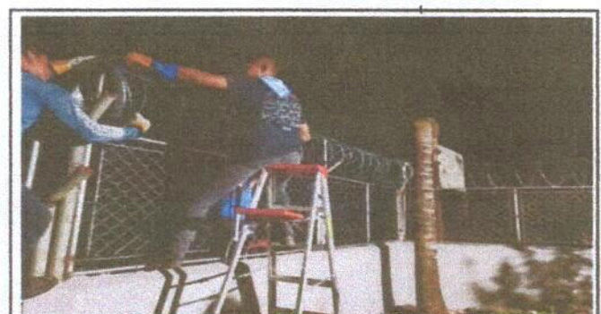
Foto 6: COLOCACION DE CUADROS Y ALAMBRE
