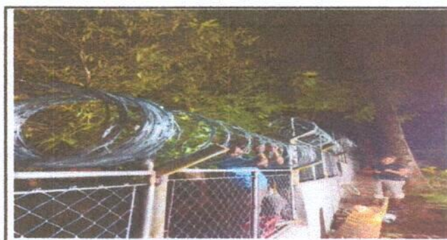
Foto 5: COLOCACION DEL ALAMBRE
