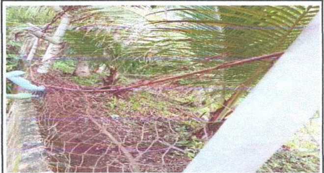
Foto 2: VISTA GENERAL DE LA ALTURA DE LA MALLA, 1.30 MTS.
