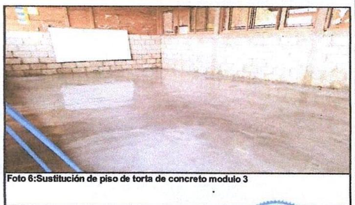
Foto 6: Sustrucción de piso de torta de concreto modulo 3
