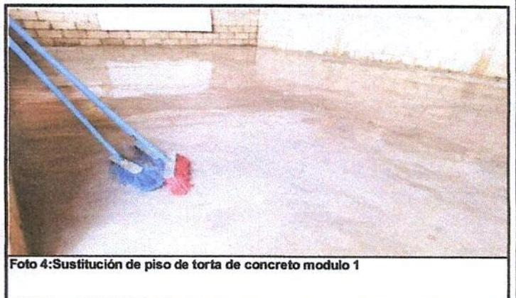
Foto 4: Sustrucción de piso de torta de concreto modulo 1
