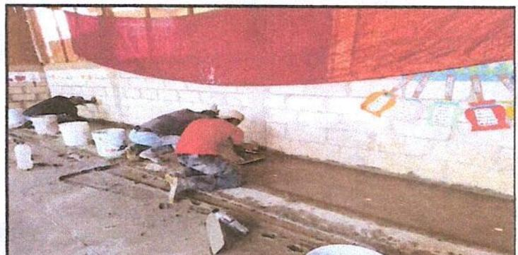
Foto 4: Sustitución de piso de torta de concreto modulo 1
