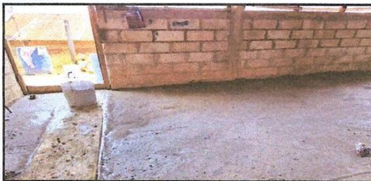
Foto 5: Sustitución de piso de torta de concreto modulo 2
