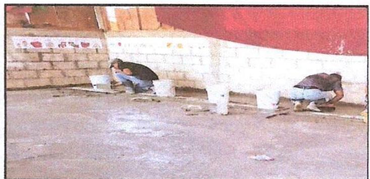
Foto 6: Sustitución de piso de torta de concreto modulo 3
