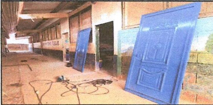
Foto 1: Sustitución de puerta del modulo 1
