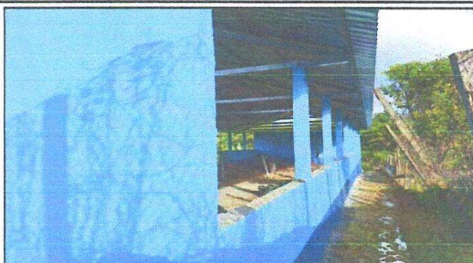
Foto 2: Sustitución de lámina, por lámina troquelada, sustitución de capote para lámina troquelada y sustitución de estructura de soporte de madera por metal.
