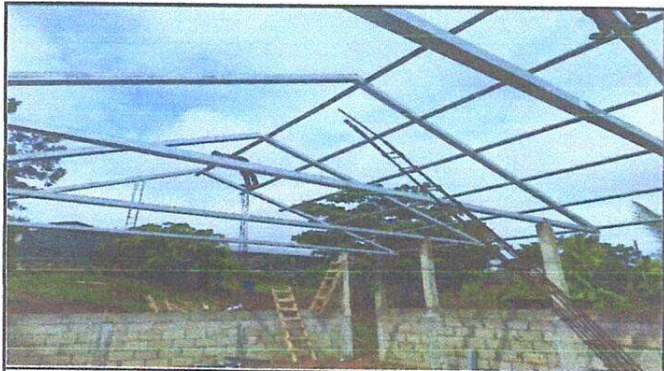
Foto 3: Aulas 1,2,3 Sustitución de lámina, por lámina troquelada, sustitución de capote para lamina troquelada y sustitución de estructura de soporte de madera por metal.
