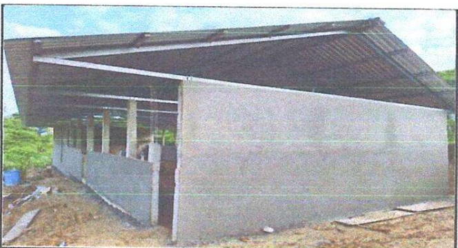
Foto 5: Aula 2 Sustitución de lámina, por lámina troquelada, sustitución de capote para lámina troquelada y sustitución de estructura de soporte de madera por metal.
