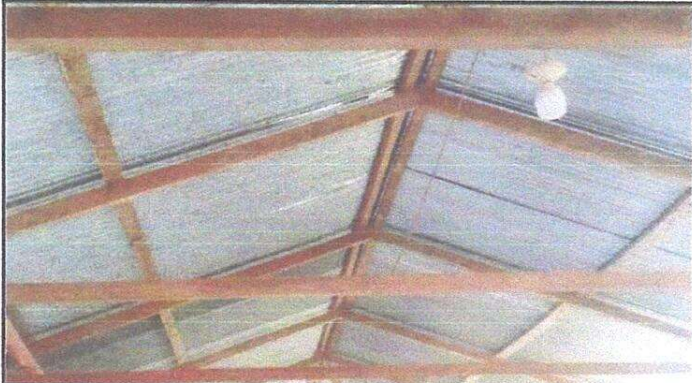
Foto1: Sustitución de lámina, por lámina troquelada, sustitución de capote para lámina troquelada y sustitución de estructura de soporte de madera por metal.
