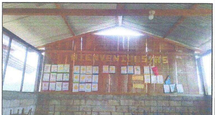
Foto 4: aula 1 Sustitución de lámina, por lamina troquelada, sustitución de capote para lamina troquelada y sustitución de estructura de soporte de madera por metal.
