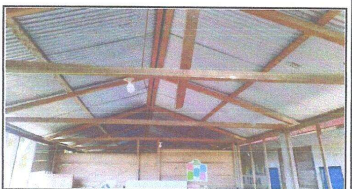
Foto 6: Aula 3 Sustitución de lámina, por lámina troquelada, sustitución de capote para lámina troquelada y sustitución de estructura de soporte de madera por metal.
