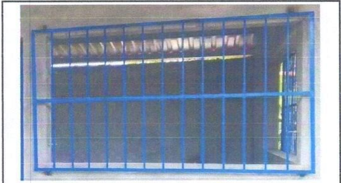
Foto 4: Sustitución de balcones de metal.
