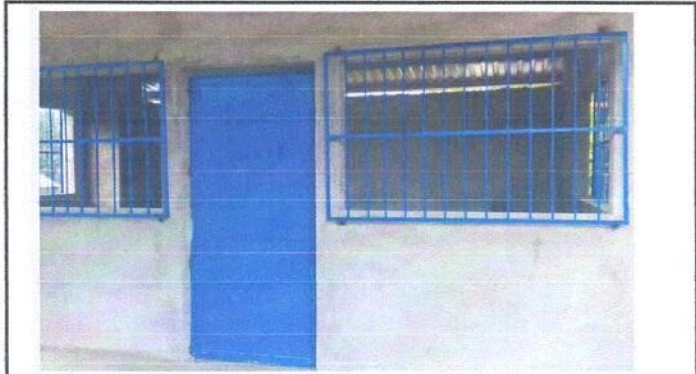
Foto 3: Sustitución de puerta de madera, por metal.
