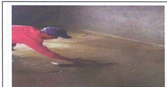
Foto 5: Sustitución de piso de torta de concreto.
