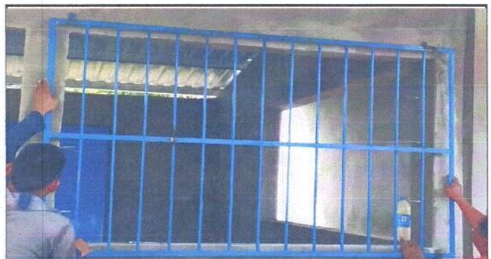
Foto 4: Sustitución de balcones de metal.
