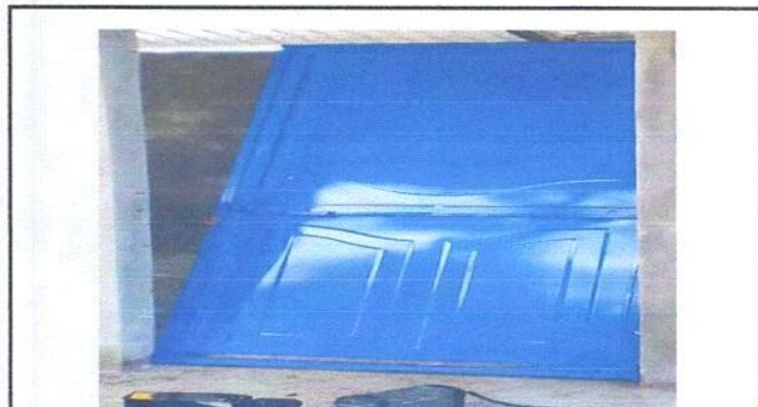
Foto 3: Sustitución de puerta de madera, por metal.
