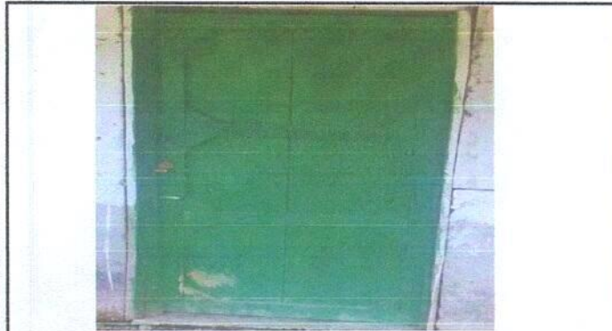
Foto 3: Sustitución de puerta de madera, por metal.
