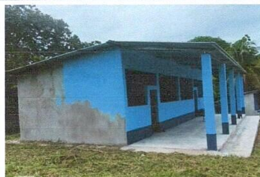
Foto 4: finalizacion de banquetas e inicio de la fase de pintura.
