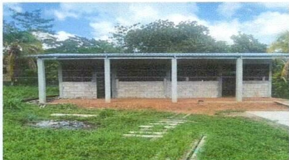
Foto 1: vista de la fase de relleno listo para realizar el piso
