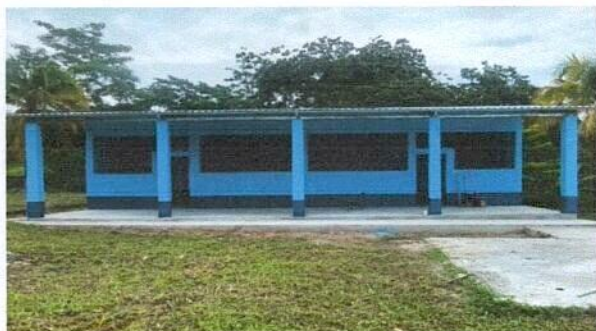
Foto 5: terminacion de la fase de pintura
