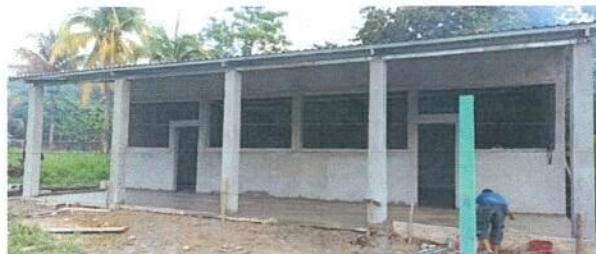
Foto 2: fase de elaboracion del piso o piso ya hecho.
