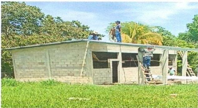
Foto 5: vista de la fase de colocación del techo del aula.
