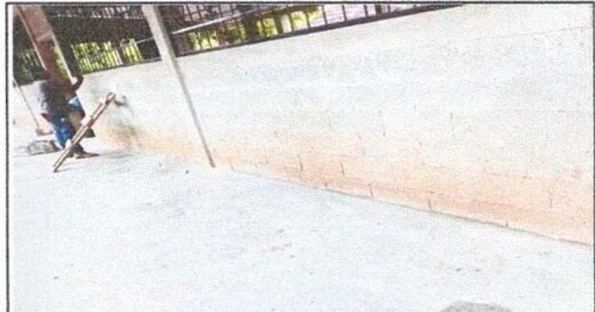
Foto 6: Sustitución de pared de madera por block
