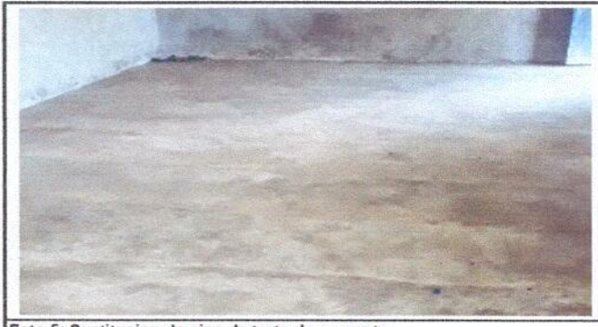
Foto 5: Sustitucion de piso de torta de concreto.
