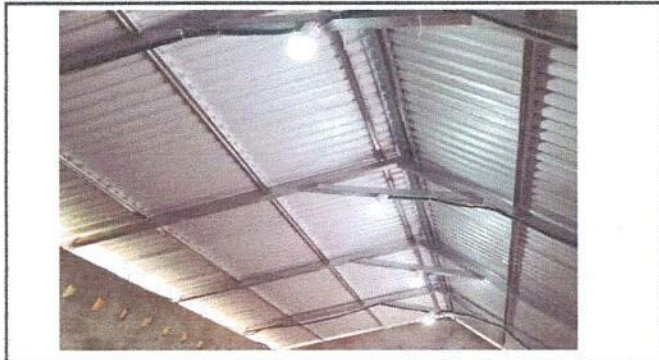
Foto 4: Sustitucion de estructura de madera por metal.
