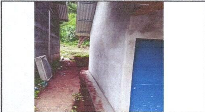
Foto 3: Sustitucion de puerta de madera por metal.
