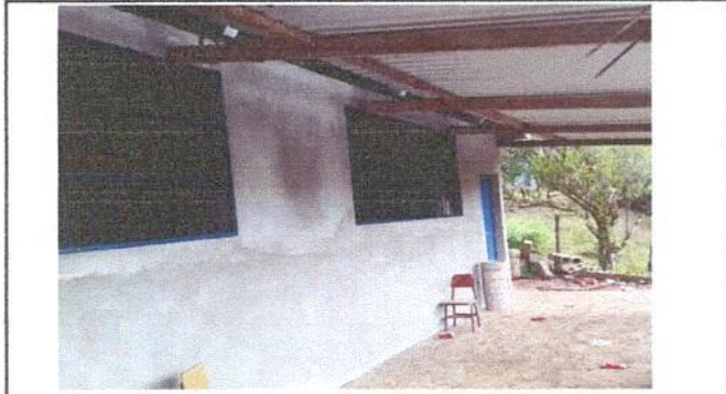
Foto 2: Sustitucion de ventana por valcon.
