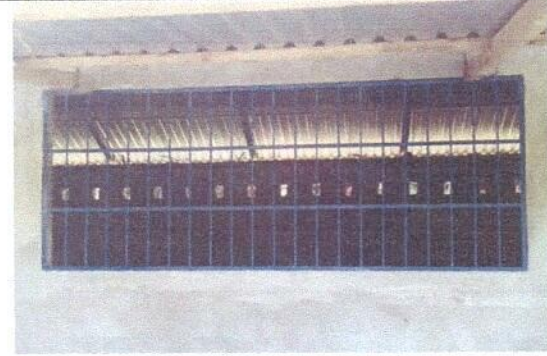
Foto 2: Sustitucion de ventana por valcon.
