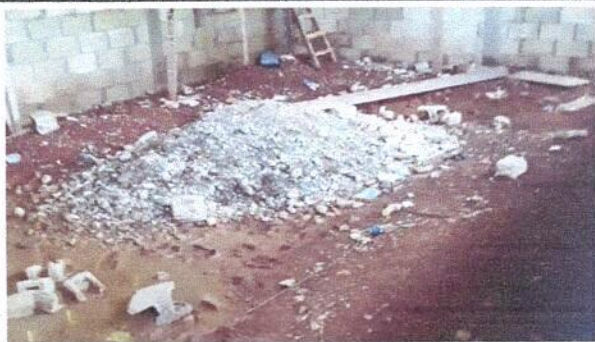
Foto 5: Sustitucion de piso de torta de concreto.
