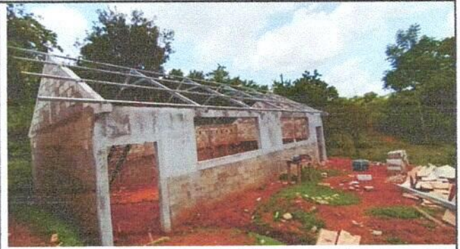
Foto 4: Sustitucion de estructura de madera por metal.
