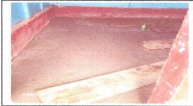
Foto 2: Sustrucion de pisos de torta de cemento.
