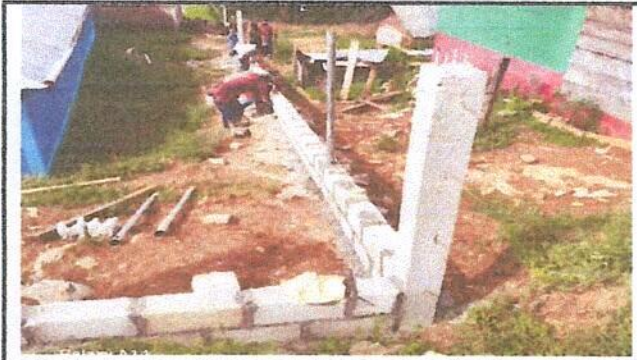
Foto 3: Reparacion de muro perimetral de block con tubo hg y malla galvanizada.
