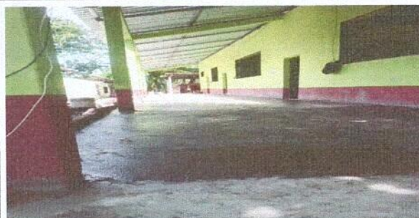
Foto 5: SUSTITUCION DE PISO
