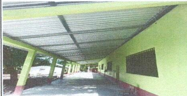
Foto 2: SUSTITUCION DE MADERA POR METAL EN EL CORREDOR
