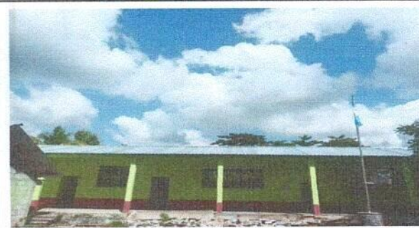
Foto 3: CAMBIO DE TECHADO
