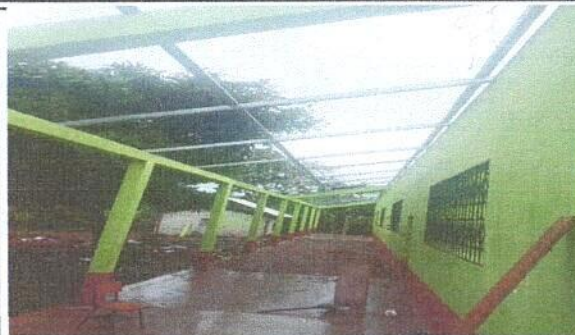
Foto 2: SUSTITUCION DE MADERA POR METAL EN EL CORREDOR
