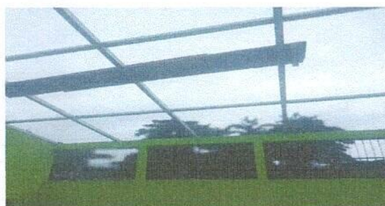
Foto 4: SUSTITUCION DE MADERA POR METAL EN EL AULA
