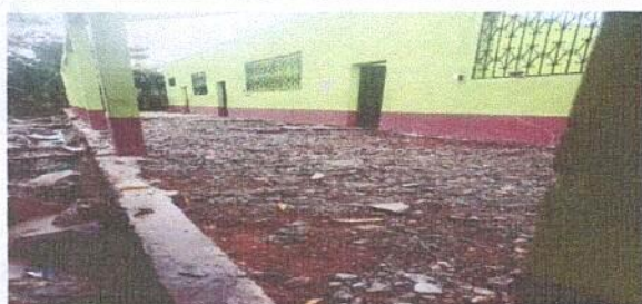
Foto 5: SUSTITUCION DE PISO
