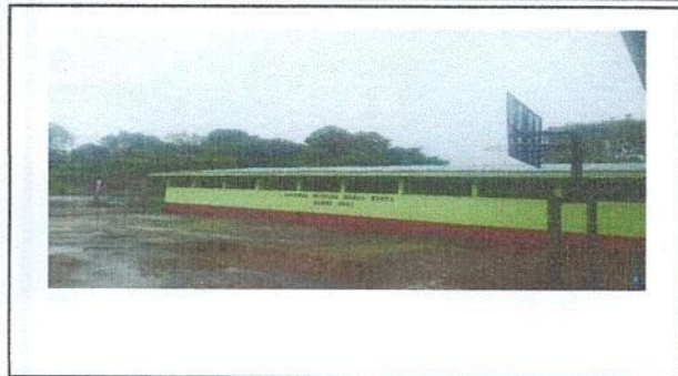
Foto1: 328 M DE TECHADO
