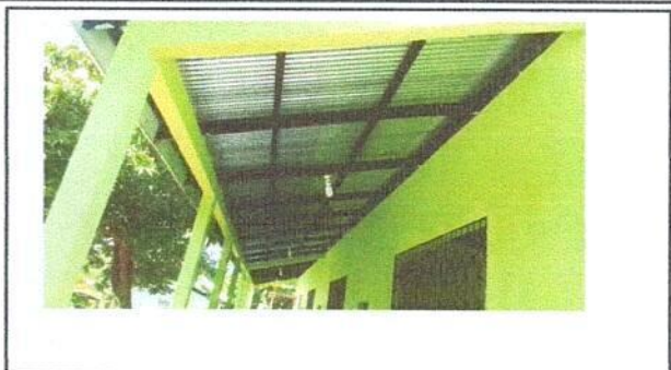
Foto 2: SUSTITUCION DE MADERA POR METAL EN EL CORREDOR
