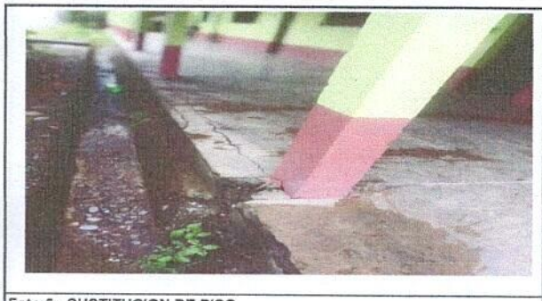
Foto 5: SUSTITUCION DE PISO
