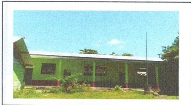
Foto 3: CAMBIO DE TECHADO
