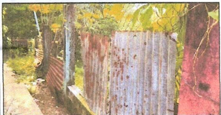
Foto 3: sustitución de malla del centro educativo público.
