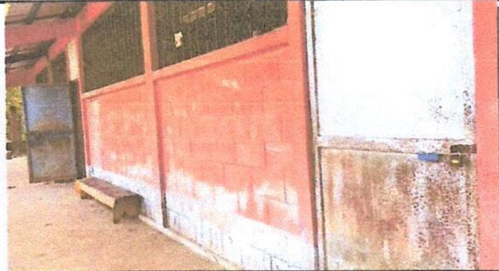
Foto mantenimiento puerta de metal
