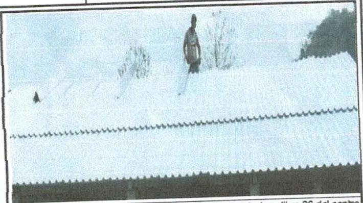
Foto 2: Sustitución de lamina, por lamina troquelada aluzin calibre 26 del centro educativo.
