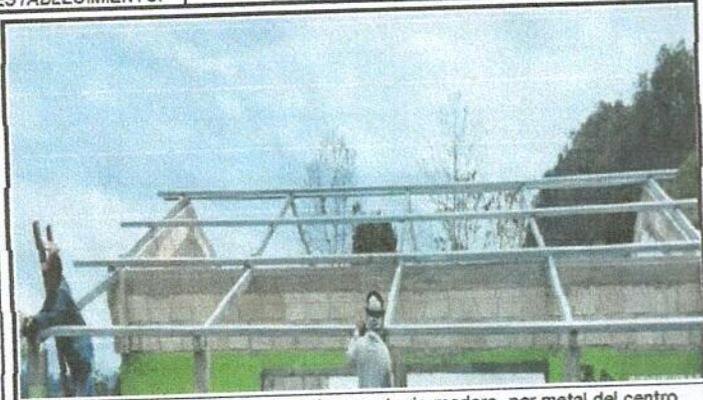
Foto 1: Sustitución de estructura de soporte de madera, por metal del centro educativo.
