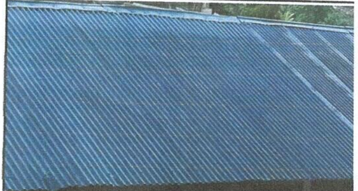
Foto 2: Sustitución de lamina, por lamina troquelada aluzin calibre 26 del centro educativo.
