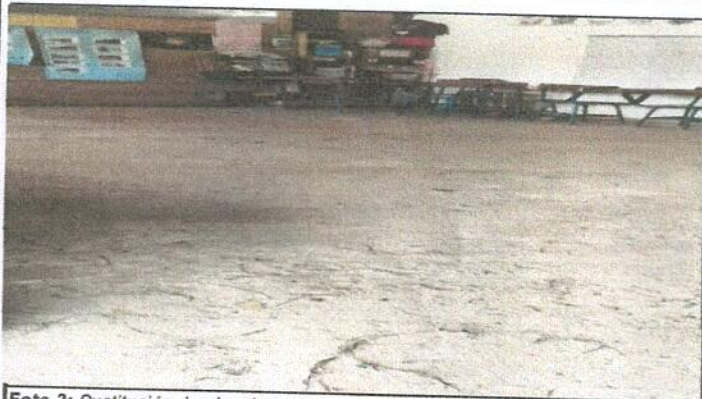
Foto 3: Sustitución de piso de torta de cemento por piso de granito.
