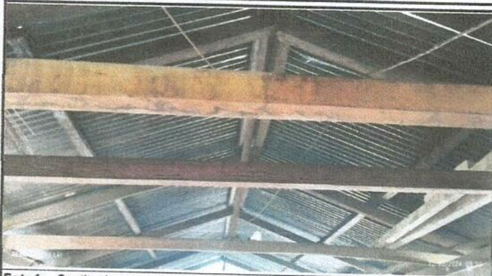
Foto 1: Sustitución de estructura de soporte de madera, por metal del centro educativo.
