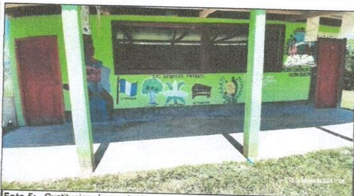
Foto 5: Sustitución de puerta de madera por metal del centro educativo.
