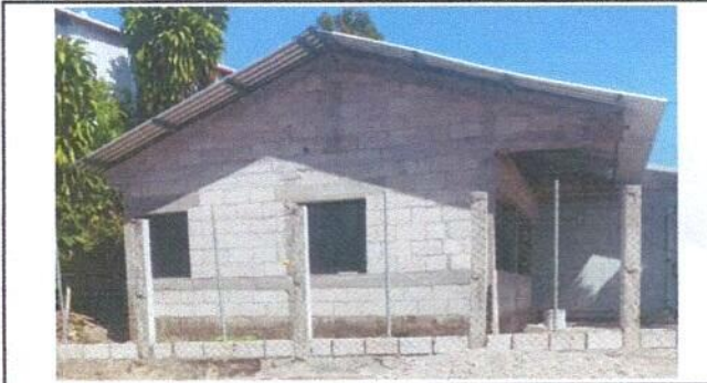
Foto 6: Reparación de muro perimetral con tubo hg y malla galvanizada
