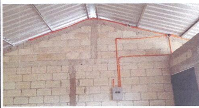
Foto 2: Sustitución de estructura de madera por metal de la cocina
