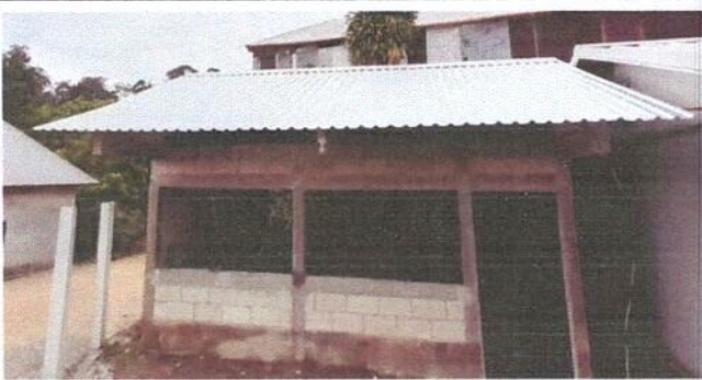
Foto1: Sustitución de lámina por lámina troquelada
