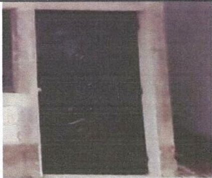
Foto 3: Sustitución de puerta de madera por metal
