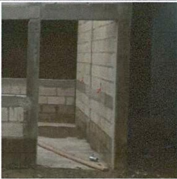
Foto 3: Sustrucción de puerta de madera por metal
