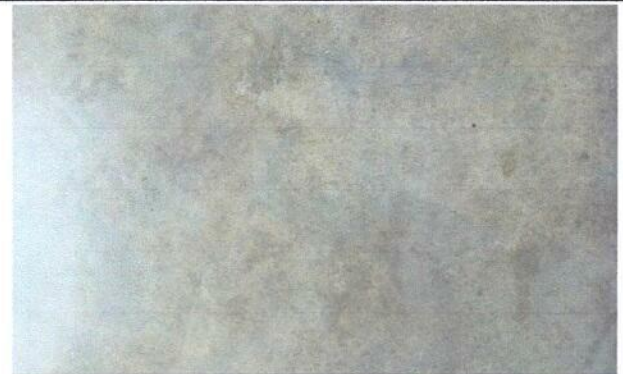
Foto 4: Reparación de piso.
