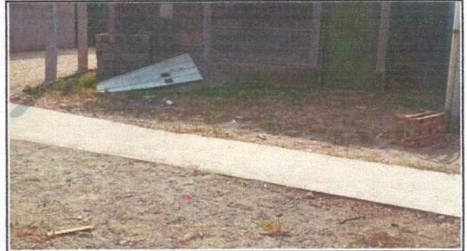
Foto 4: Reparación de piso.
