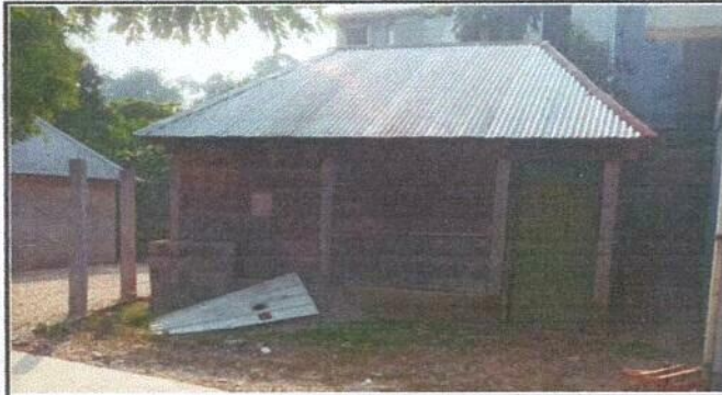
Foto1: Sustitución de lámina por lámina troquelada
