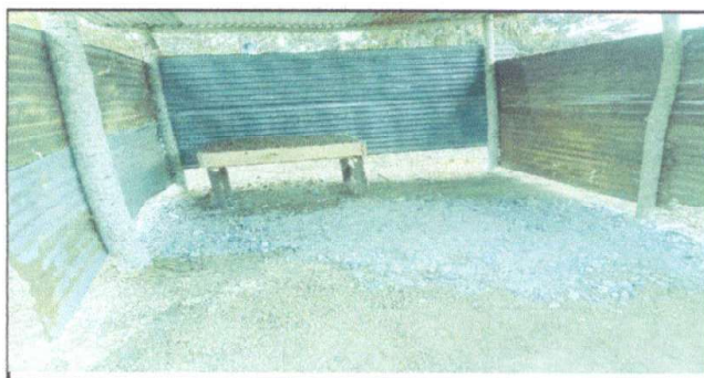
Foto 6: Vista interna de las instalaciones de la cocina.
