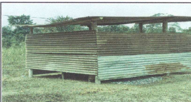
Foto 5: Vista externa de la cocina.
