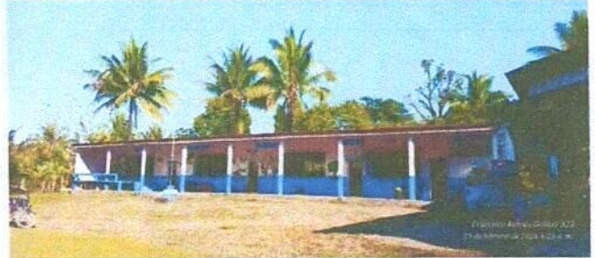
Foto 2: Sustitucion de muro perimetral
