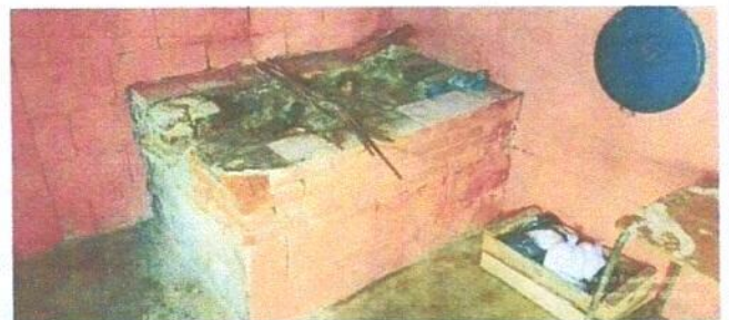
Foto 6: Reparacion de estufa
