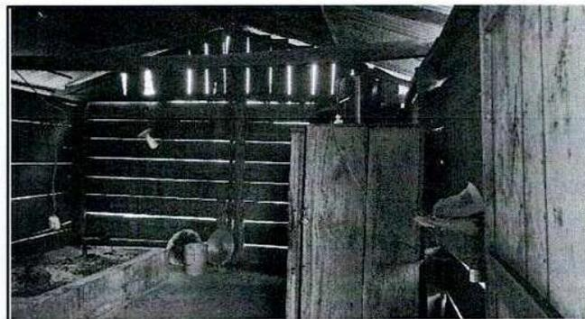
Foto 4: Lámina y estructuras de madera en mal estado
