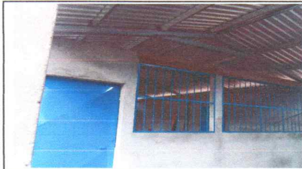
Foto 1: FINALIZACIÓN DE ESTRUCTURA DE TECHO
