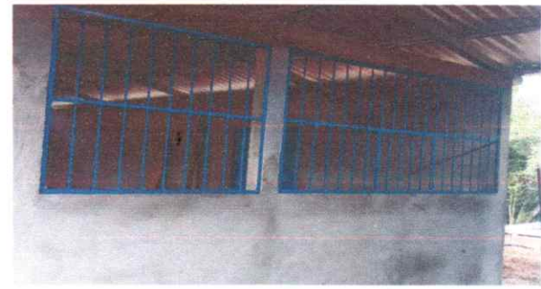
Foto 4: FINALIZACIÓN DE VENTANAS
