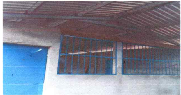
Foto 2: FINALIZACIÓN DE CUBIERTA DE LÁMINA
