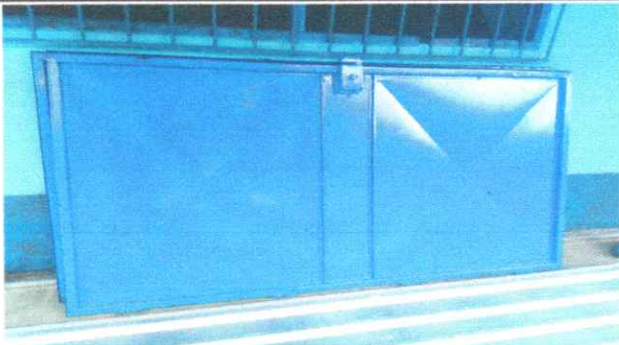
Foto 3: COLOCACIÓN DE PUERTAS
