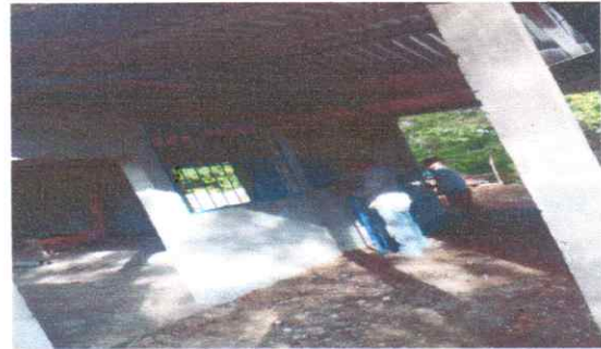
Foto 4: COLOCACIÓN DE VENTANAS
