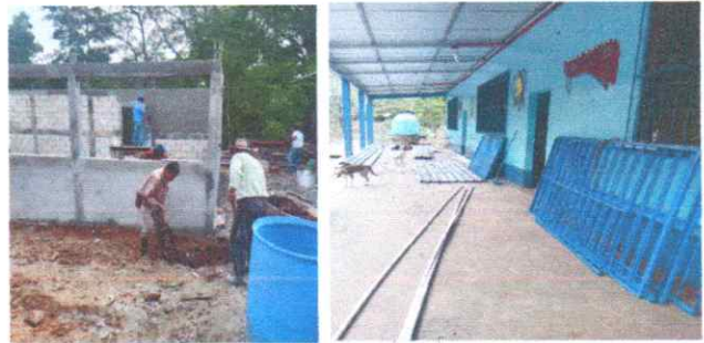
Foto 6: MANO DE OBRA ESPECIALIZADA
