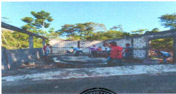
Foto 5: REPARACIÓN DE PISO DE TORTA
