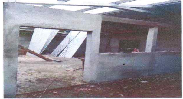
Foto 2: COLOCACIÓN DE CUBIERTA DE LÁMINA
