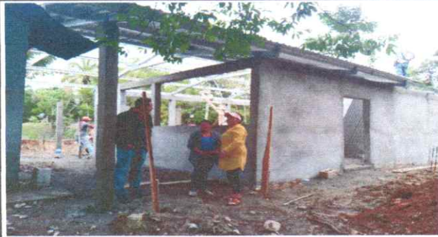
Foto1: COLOCACION DE ESTRUCTURA DE TECHO
