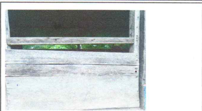
Foto 2: SUSTITUCION DE VENTAS Y PUERTAS DE MADERA POR METAL
