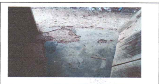
Foto 6: REPARACION DE TORTA DE CEMENTO
