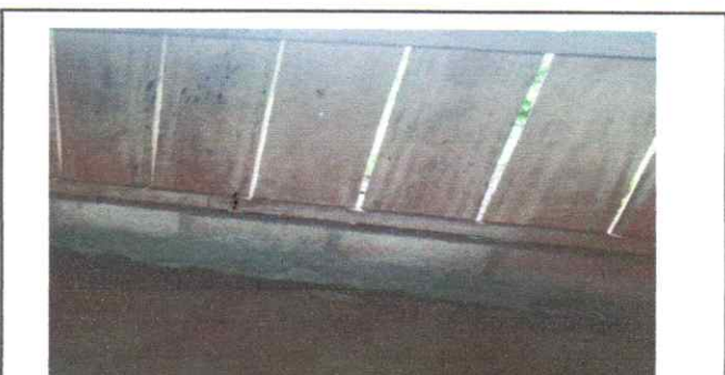
Foto 4: LEVANTADO DE PAREDES
