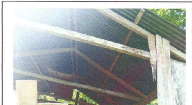
Foto 1: CUBIERTA DE LAMINA Y ESTRUCTURA DE TECHO
