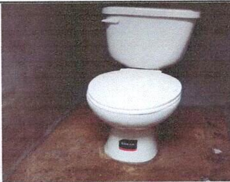
Foto 3: Sustitucion de inodoro.
