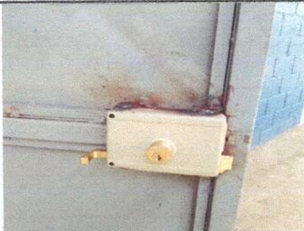
Foto 5: Sustitucion de chapa.
