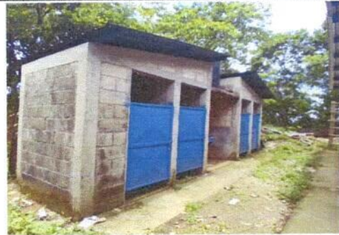
Foto 2: Sustitucion de puerta en servicios sanitarios.
