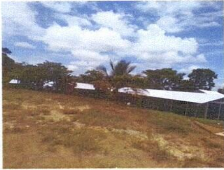
Foto 1: Sustitucion de lamina, por lamina troquelada aluzinc del centro educativo.
