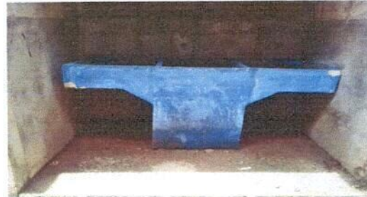
Foto 4: Sustitucion de pila.
