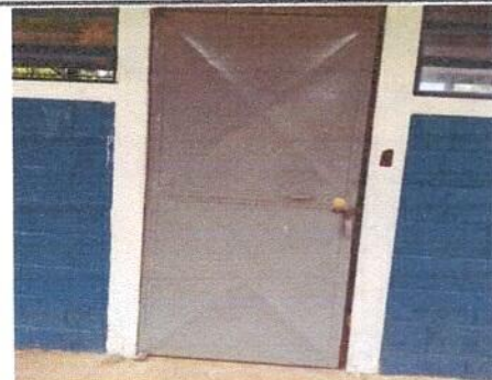
Foto 6: Sustitucion de puerta.
