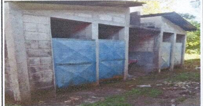
Foto 2: Sustitución de puerta en servicios sanitarios
