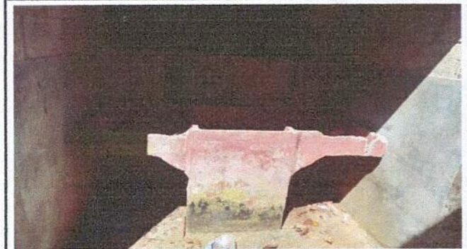
Foto 4: Sustitución de pila
