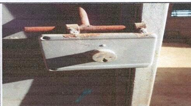
Foto 5: Sustitución de chapa
