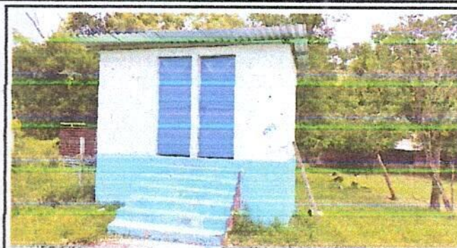
Foto 8: Reparación de letrina, puerta, pared, lámina de metal por lámina troquelada de calibre 26
