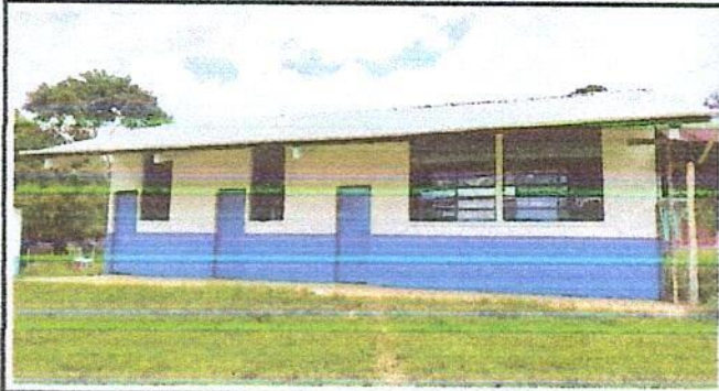
Foto1: Sustitución de láminas deterioradas por lámina troquelada calbre 26 del centro educativo
